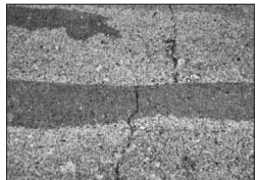
Risse am Bau
